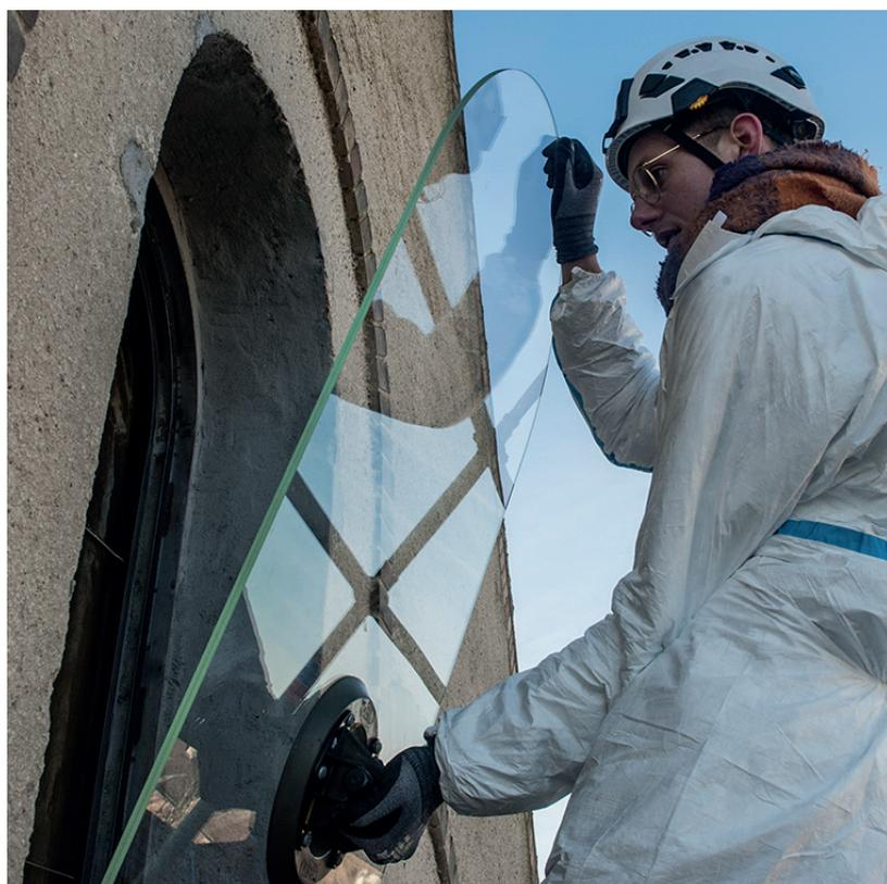
L'opération de pose des verrières restaurées est précédée par l'installation des verres de protection extérieure, soigneusement calfeutrés afin d'assurer la ventilation des verrières par l'intérieur, évitant ainsi toute pollution directe par l'extérieur.
